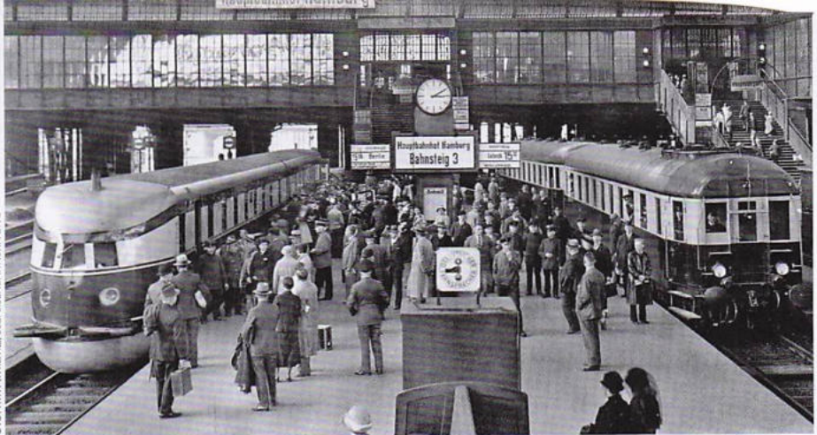
Hamburg Hauptbahnhof, 1935: Der VT877 wird um 15:16 Uhr ohne Halt nach Berlin abfahren, der Dampftriebwagen DT 2000 der LBE dagegen um 15:30 Uhr Richtung Lübeck.
